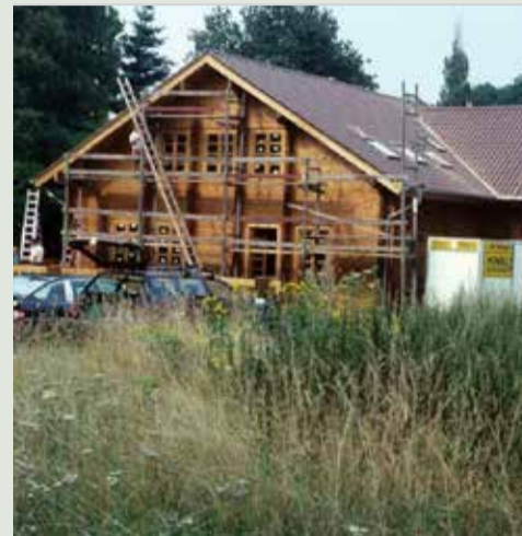
Die Biologische Station im Bau. Foto Georg Sennert
