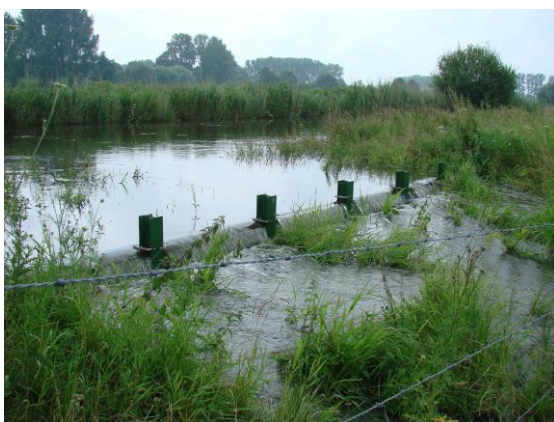
Einlauf der Niers in die Blänkenfläche am 10.07.2014
